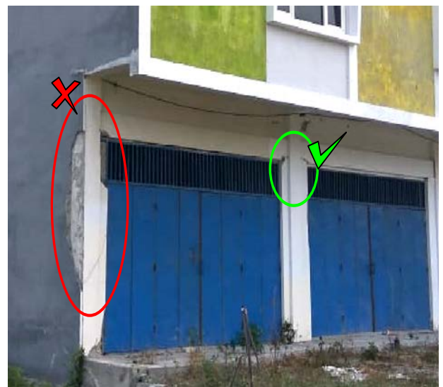
b. Damaged edge column
